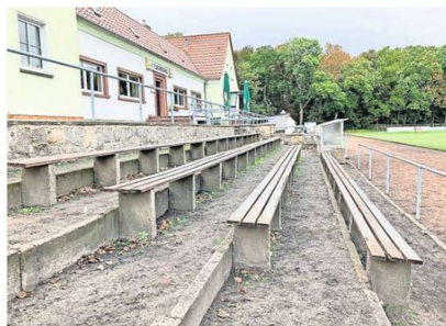
Blick in das Krostitzer Stadion, es soll saniert werden. Ende des Jahres werden erste Arbeiten beginnen. FOTO: HEIKE LIESAUS
